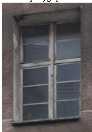
Obecny wygląd okna
